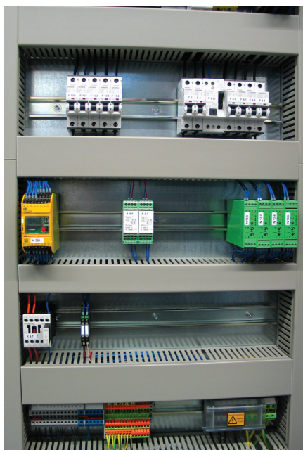
Bild 4. Das konfigurierbare Sicherheitsschaltgerät „PNOZmulti-Mini“ überwacht alle Sicherheitsfunktionen und benötigt dabei nur wenig Platz im Schaltschrank
