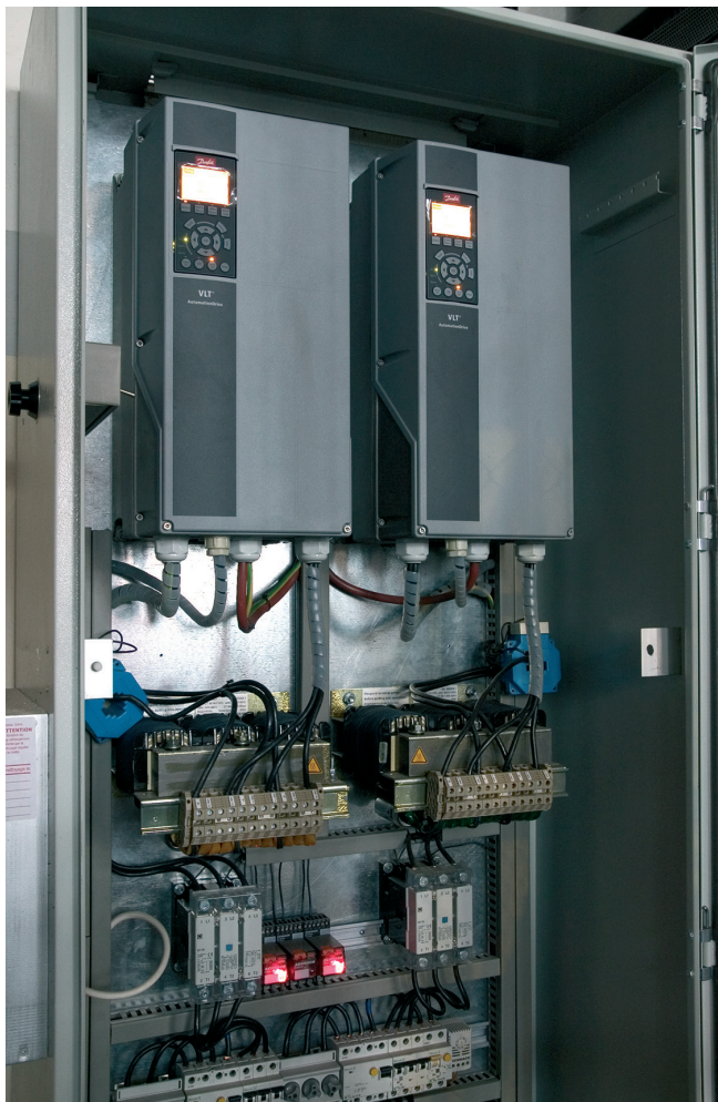
Bild 2. Kommt ein Frequenzumrichter zum Einsatz, so sind gerade bei älteren Motoren zusätzliche Sinus- oder du/dt -Filter zu deren Schutz erforderlich
